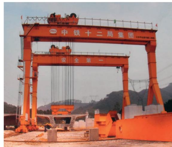
中铁十二局施工现场
