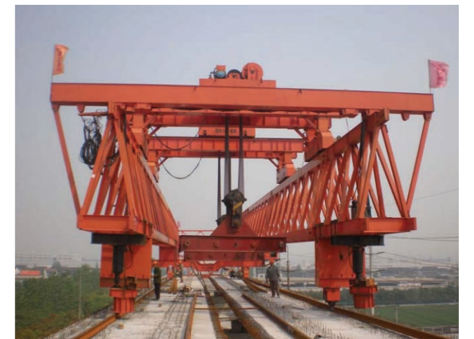
中铁一局施工现场
