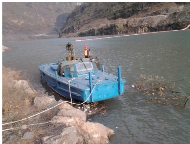
200吨卷扬机用于世界第二大水电站— 溪洛渡水电站拦漂工程现场
