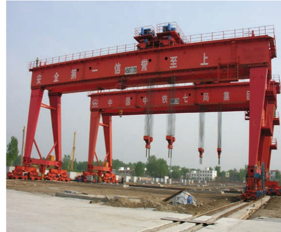
中铁七局施工现场
