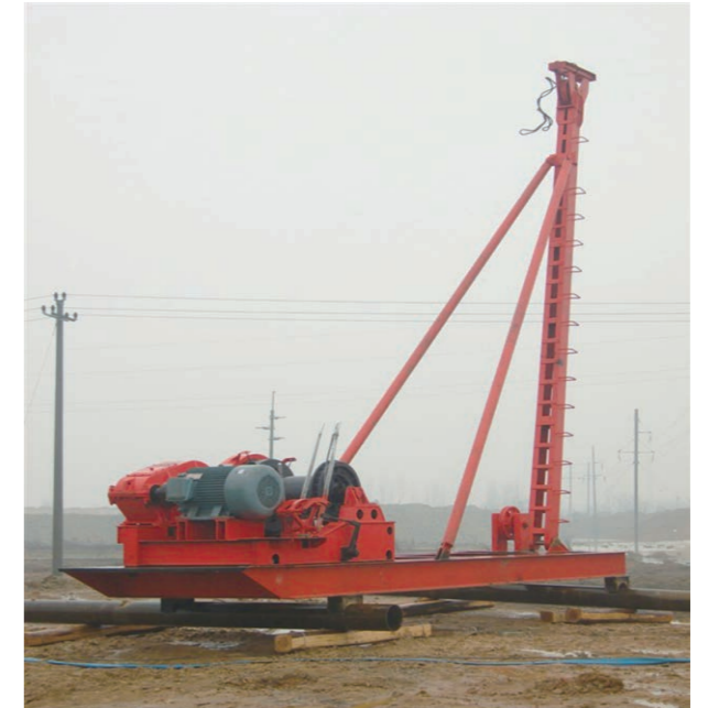
钻机配套卷扬机施工现场
