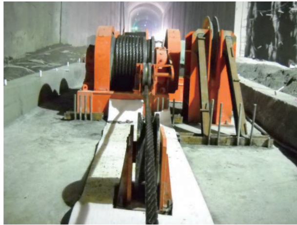
溪洛渡施工现场
